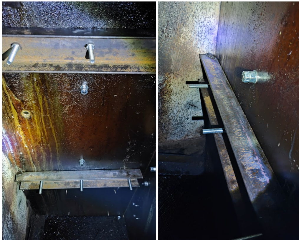
Wzmocnienie podstawy wentylatora zgodnie z zaleceniami specjalistów I-care.
